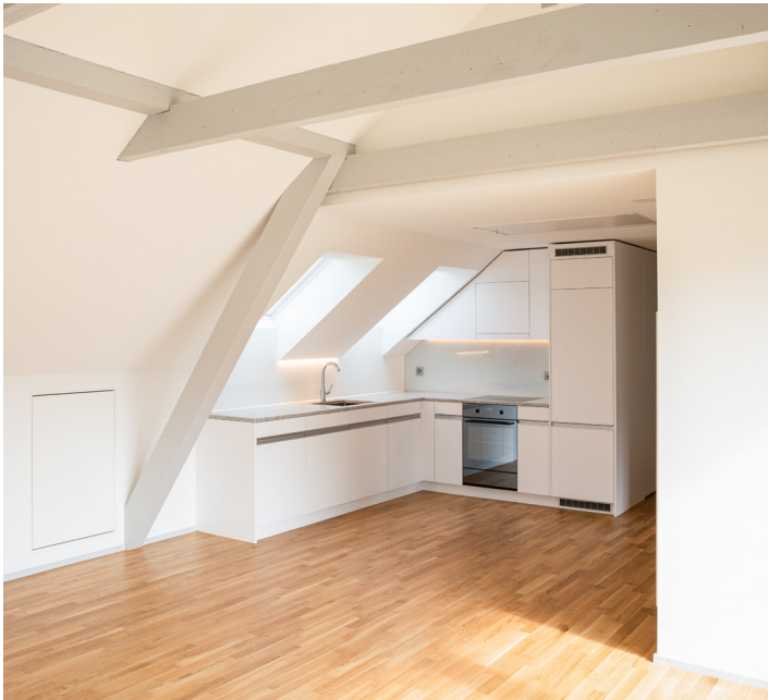
Öffnung des Dachraumes bis unter den First im Dachgeschoss
